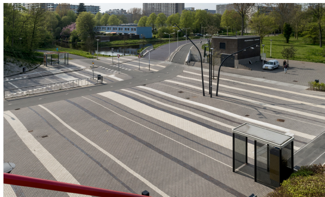
Auch im Streifenlook machen Pflasterklinker eine gute Figur, wie hier am Busbahnhof Delft Zuid in den Niederlanden. (Foto: Vandersanden)
